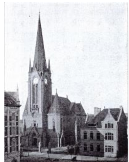
Abb. 154: Christuskirche an der Kruppstrasse,
